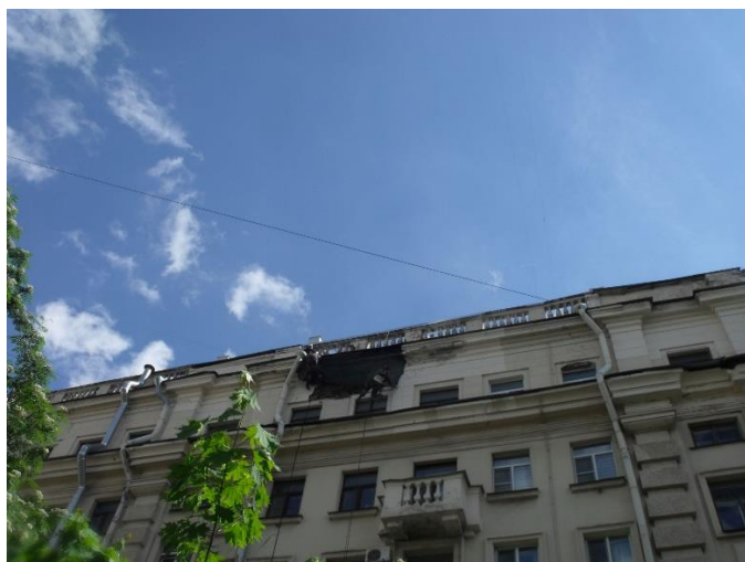
Московский проспект 161 установлены защитные сетки на ранее отбитые участки фасада дома.
