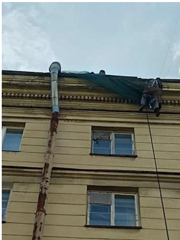
Московский проспект 161 установлены защитные сетки на ранее отбитые участки фасада дома.
