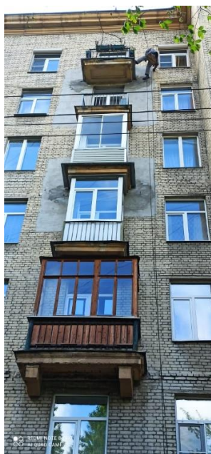
ул. Победы дом 13 отбитие слабодержащихся элементов фасада и укрытие защитной сеткой
