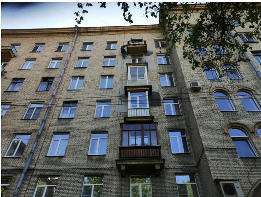
ул. Победы дом 13 отбитие слабодержащихся элементов фасада и укрытие защитной сеткой
