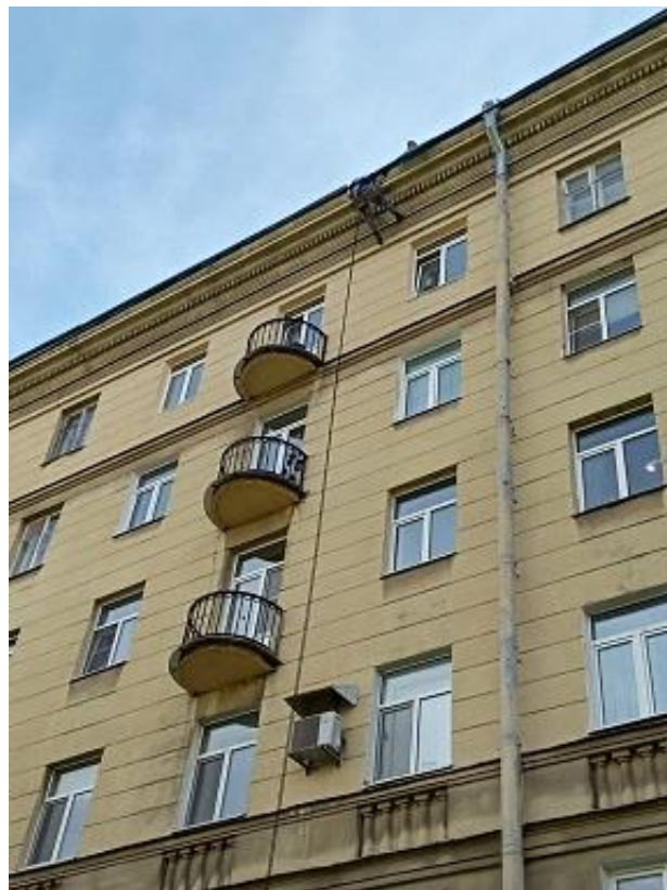
Московский проспект 161 установлены защитные сетки на ранее отбитые участки фасада дома.
