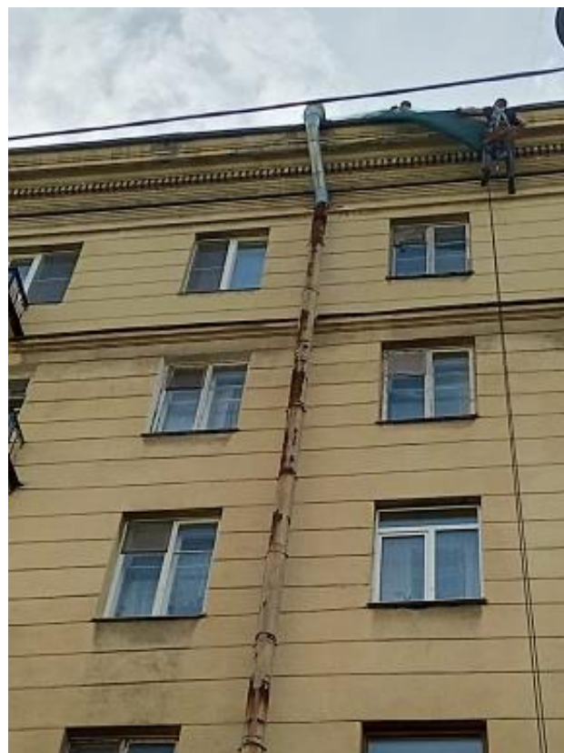
ул. Победы дом 13 отбитие слабодержащихся элементов фасада и укрытие защитной сеткой
