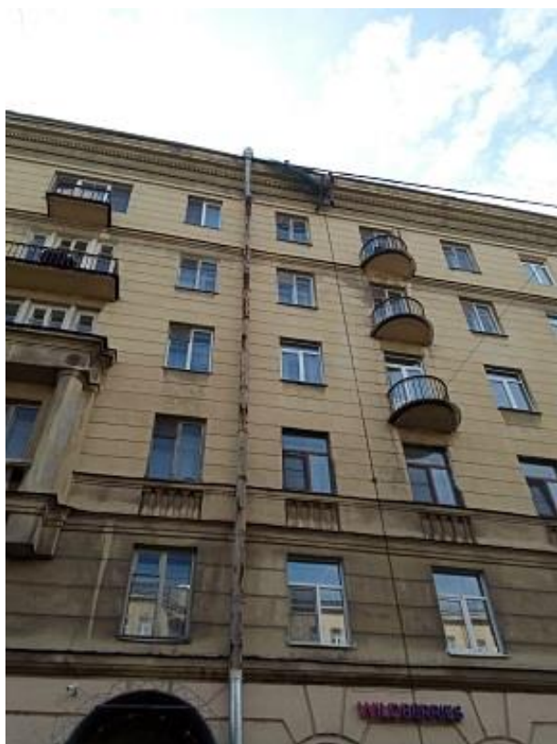
ул. Победы дом 13 отбитие слабодержащихся элементов фасада и укрытие защитной сеткой
